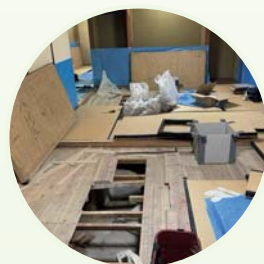
炉の寸法を1尺4寸に改める 工事後に、電気炉を設置
